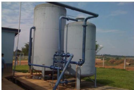
Figura 21 – ETA pressurizada
