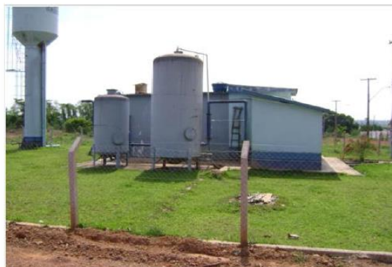
Figura 24 – Vista da ETA
