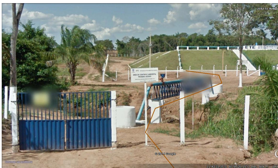
Figura 31 – Estação de Tratamento de Esgoto
