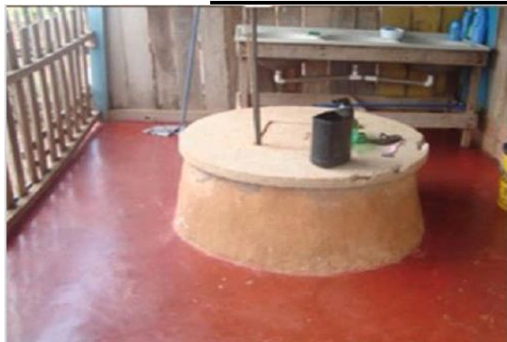
Figura 15 – Poço raso individual
