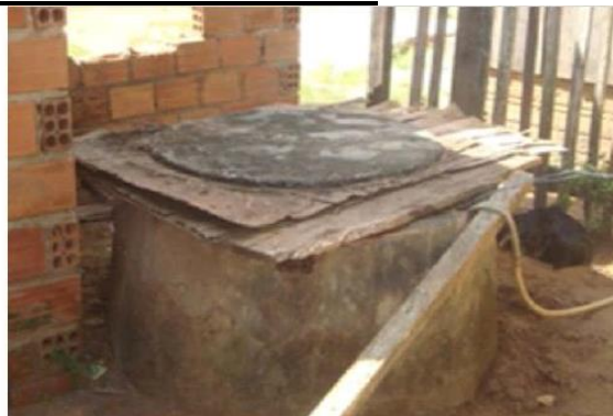
Figura 16 – Poço raso individual
