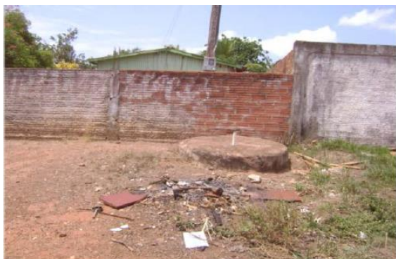
Figura 26 – Fossa Negra no passeio
