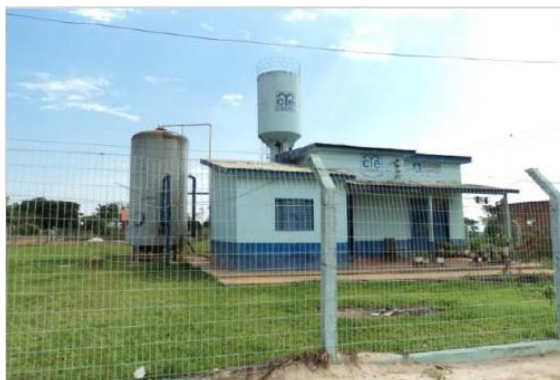
Figura 23 – Vista da ETA
