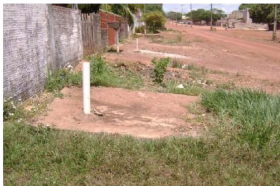
Figura 27 – Fossa Negra no passeio
