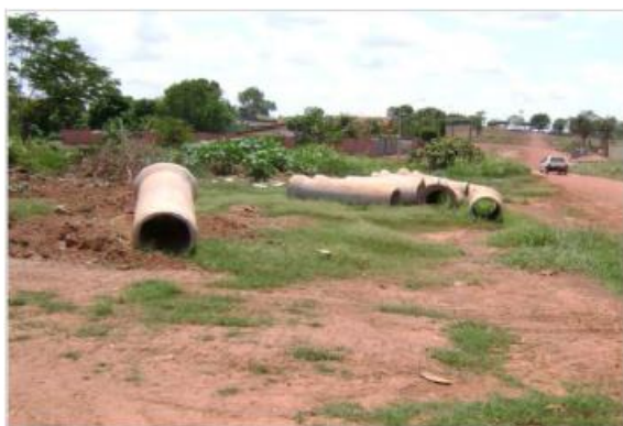
Figura 30 – Obras dos Interceptores
