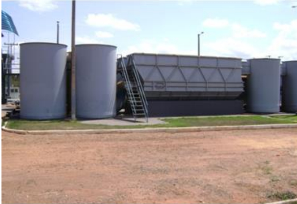
VISTA LATERAL DA ETA
