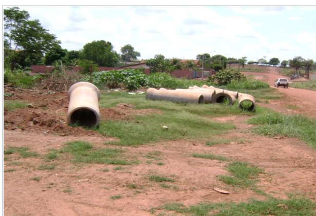
OBRAS DOS INTERCEPTORES
