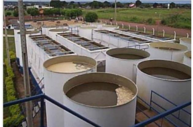
VISTA SUPERIOR DA ETA
