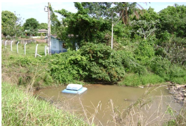
CAPTAÇÃO E EEAB
