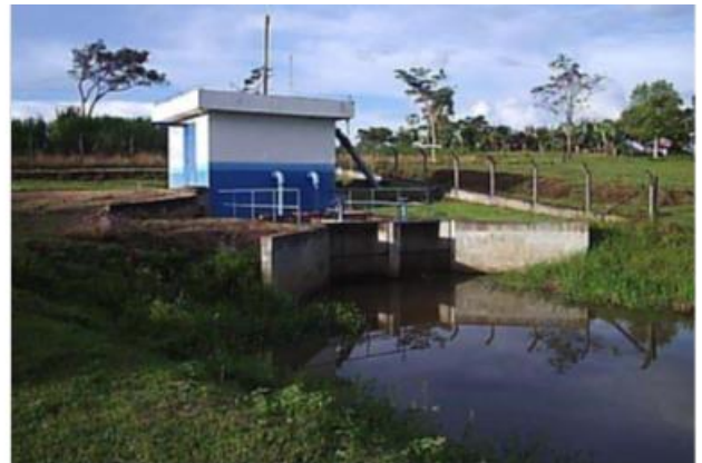
VISTA EEAB E POÇO DE SUÇÃO
