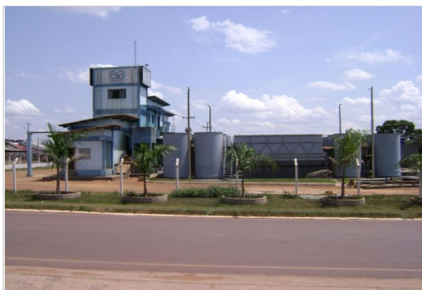
VISTA LATERAL DA ETA
