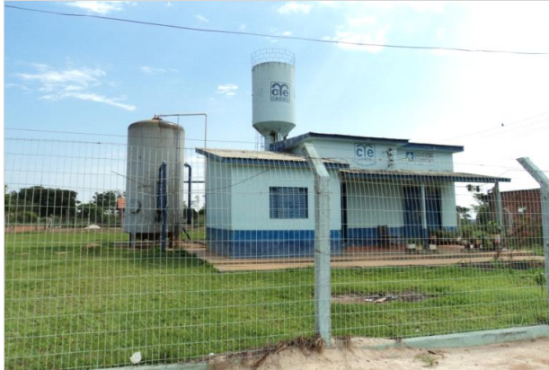
VISTA DA ETA - AO FUNDO RESERVATÓRIO APOIADO
