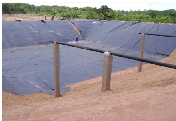
IMPERMEABILIZAÇÃO DAS LAGOAS
